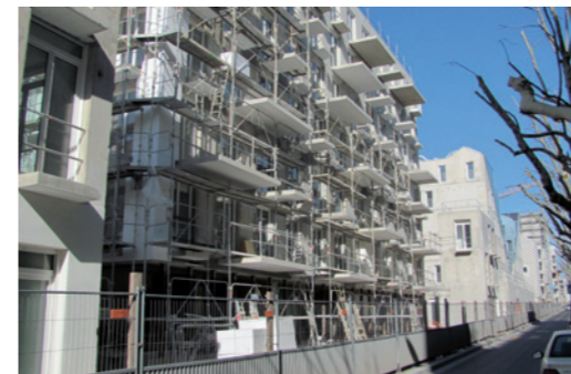
La rue Pierre Rebière en construction
